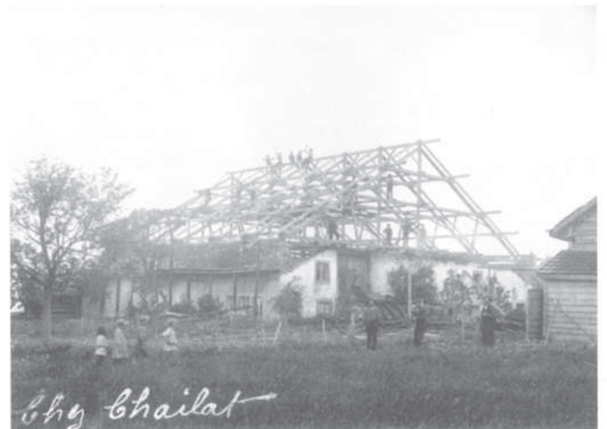
42 Ferme Chez Chailat photographiée par Eugène Cattin à deux époques : dans son état originel et pendant la transformation exhaussant le bâtiment et modifiant la toiture à quatre pans en un vaste toit à deux pans.
