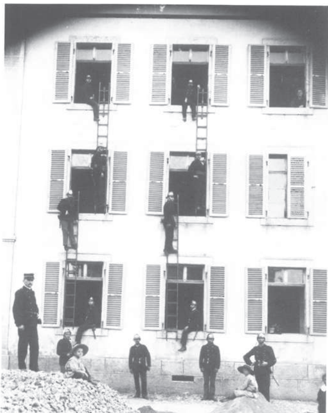
Les pompiers des Bois, «escaladant» la façade de l'école.
