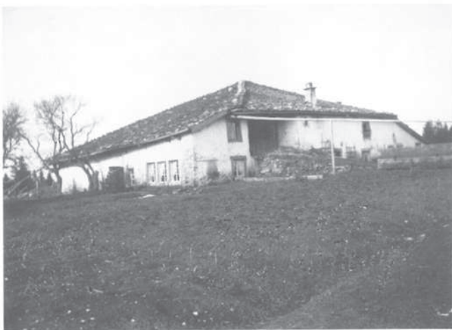
42 Ferme Chez Chailat photographiée par Eugène Cattin à deux époques : dans son état originel et pendant la transformation exhaussant le bâtiment et modifiant la toiture à quatre pans en un vaste toit à deux pans.
